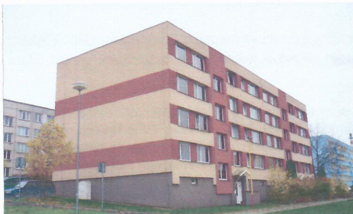
Foto č.2 – pohled jihovýchodní
