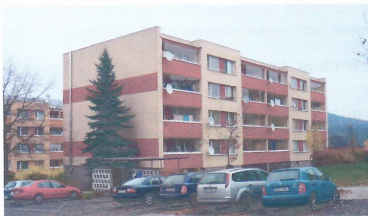
Foto č.1 – pohled severozápadní
