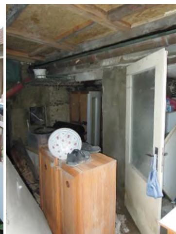
zastřešení dvorního traktu
