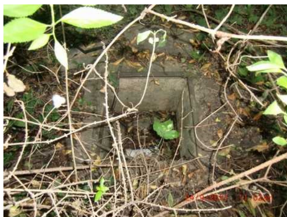
původní vodoměrná šachta
