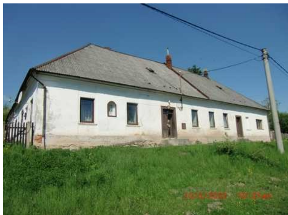
RD č.p. 357 - pohled z ulice (východní)
