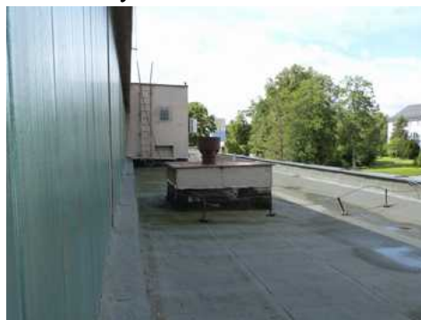
Nástavba bývalé spojovací chodby s kotelnou
