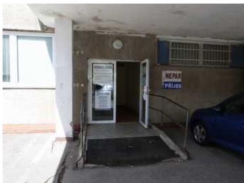
Hlavní vstup do přízemí pod terasou
