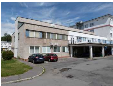
Pohled JV od silnice Nádražní
