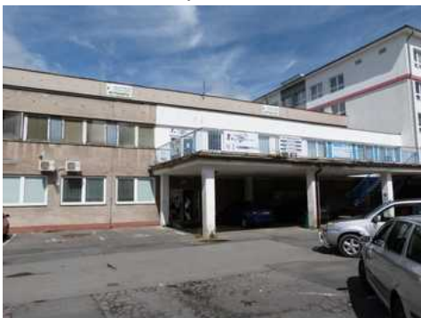
Terasa v části JV průčelí
