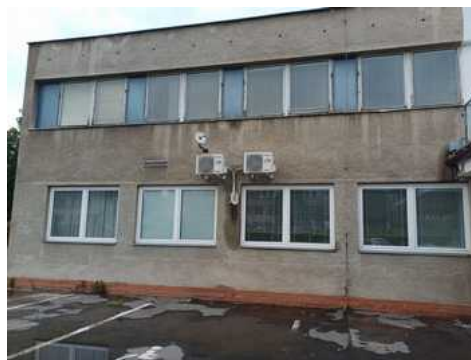
Pohled na JV průčelí volné
