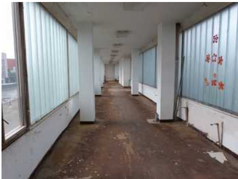
Bývalá spojovací chodby 3.NP
