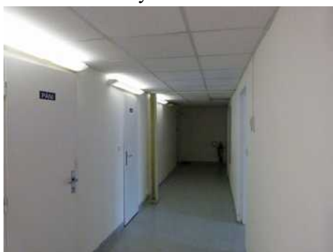
Chodba v bývalé lékárně 2.NP
