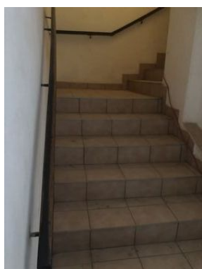
schodiště do 2.NP
