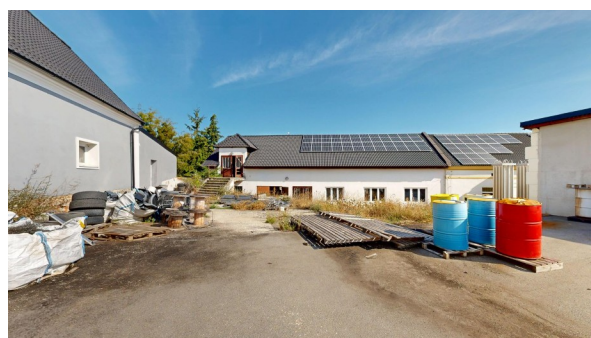
Objekty s fotovoltaickou elektrárnou
