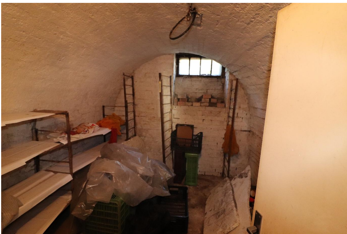
Suterén režné cihelné zdivo, valená klenba, ocelové okno
