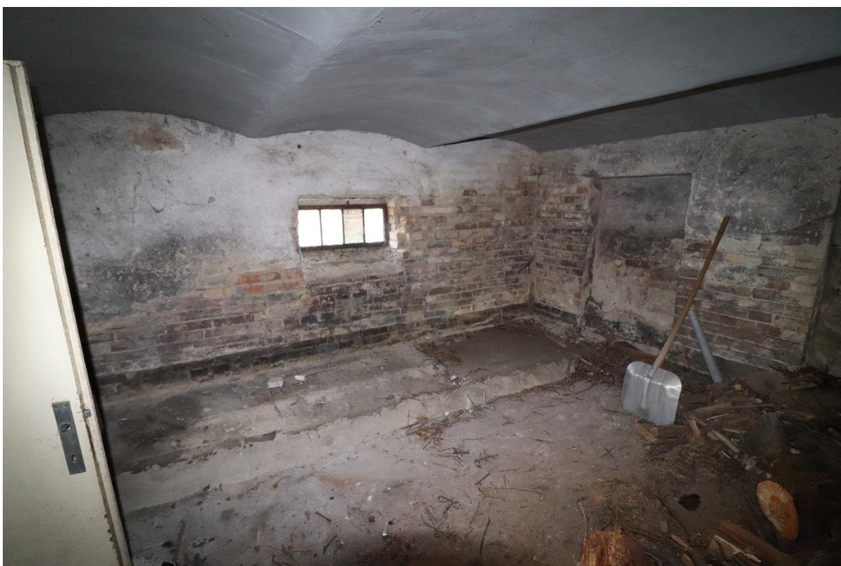
Zateplený strop ve skladu paliva, režné částečně omítnuté cihelné zdivo
