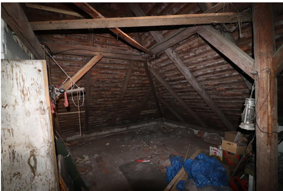
Půda konstrukce vaznicového krovu
