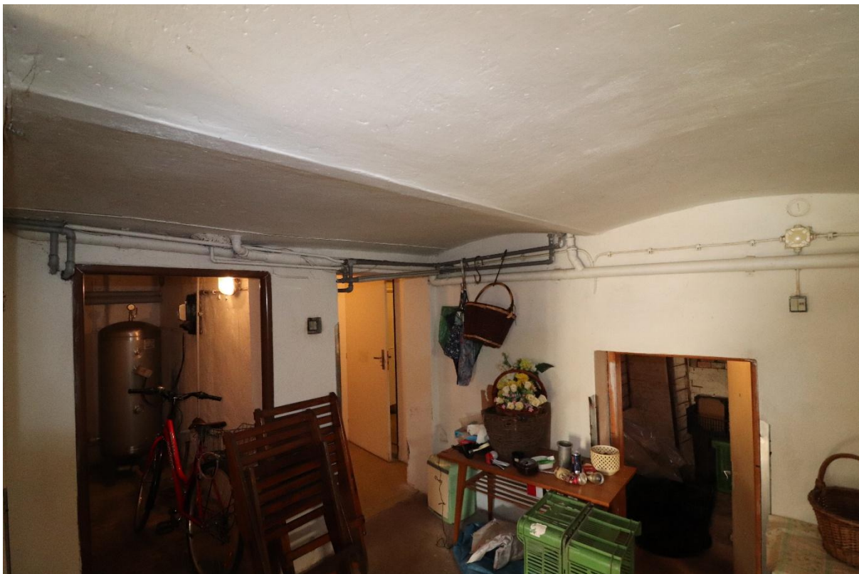
Suterén Kleinův strop bez zateplení
