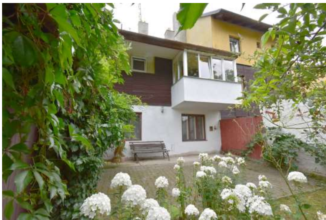
Pohled na dvorní část objektu.
