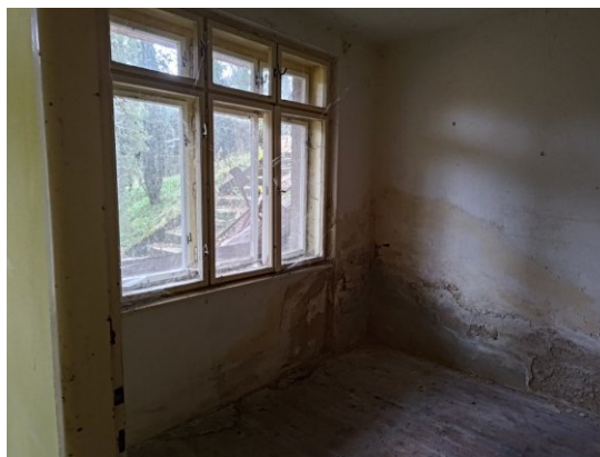
Stěna ve sklepě poškozená vlhkostí
