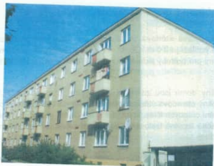
Foto č. 3 – fasáda jihovýchodní a zateplená štitová severovýchodní stěna
